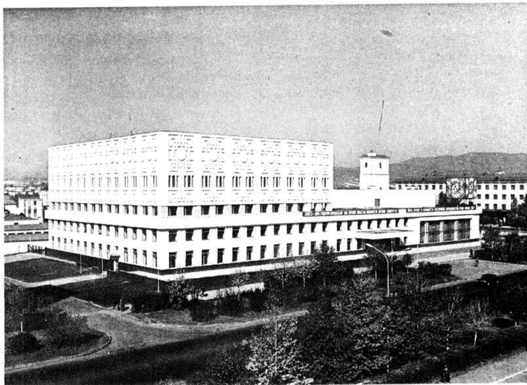
Az új információs központ épülete
